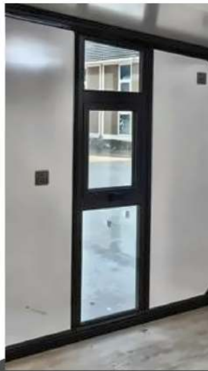
Šiltinto aliuminio langas iki grindų
